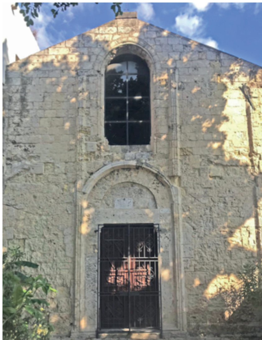
Fig. 8. Facciata principale della chiesa di San Pietro dei Pescatori , in cui si possono osservare le litologie calcaree utilizzate. Una parte dei filari di conci della zona alta della facciata sono stati evidentemente sostituiti in interventi di restauro dell'ultimo secolo.
