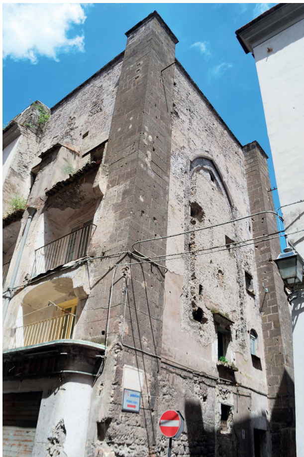
Fig. 5. Angolo sud-orientale dell'isolato 'palatino', corrispondente all'attuale chiesa di s. Domenico (Nicola Busino).
